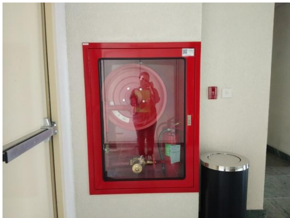
รูปที่ 2-17 ตู้เก็บสายฉีดน้ำดับเพลิง
