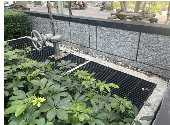
รูปที่ 2-40 บ่อพักน้ำเสียก่อนปล่อยสู่สาธารณะ
