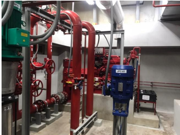
รูปที่ 2-27 ปั้มน้ำดับเพลิง
