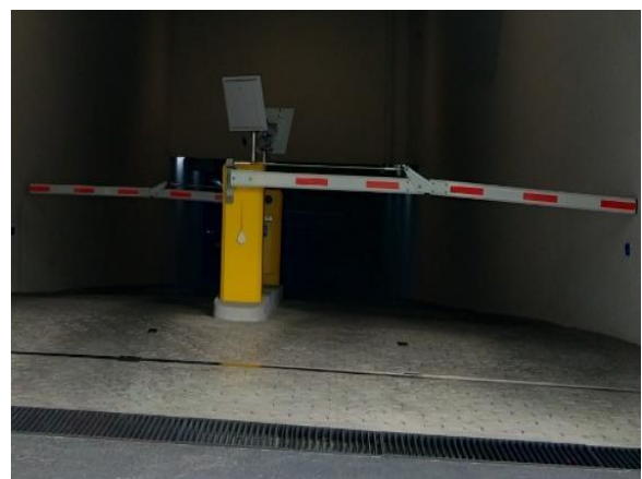
รูปที่ 2-14 ระบบ Key Card สำหรับรถยนต์เพื่อใช้ในการ ผ่านเข้า – ออกโครงการ
