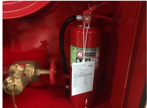
รูปที่ 2-16 ถังดับเพลิงแบบมือถือและคำแนะนำการใช้งาน
