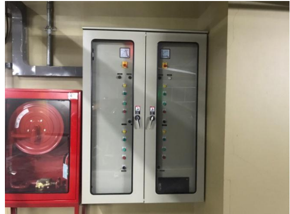
รูปที่ 2-28 ตู้ควบคุมระบบบำบัดน้ำเสียของโครงการ
