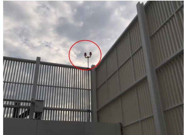
รูปที่ 2-38 ไฟเตือนการบิน Obstruction light
